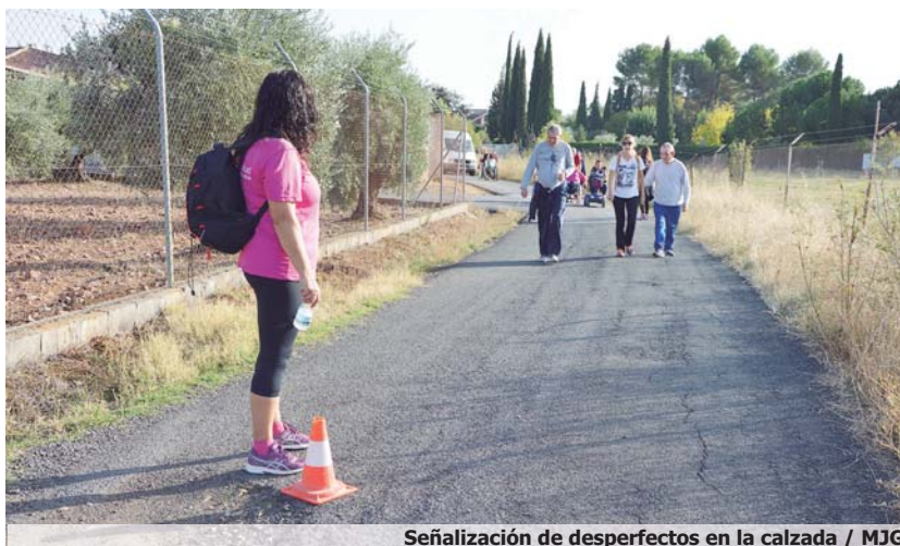
Señalización de desperfectos en la calzada / MJG
